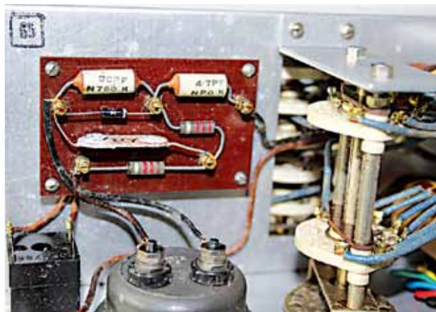
Foto MK128B zender detail plaats reserve buizen
