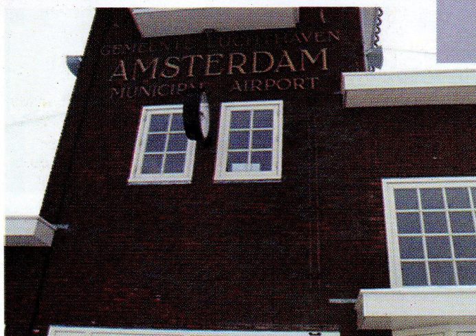
De open voedingslijn langs de muur
