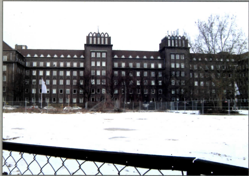
Frontaanzicht met antennes, maar nu voor het huidige telefoonverkeer. Foto PAØTOR 7-2.2006
