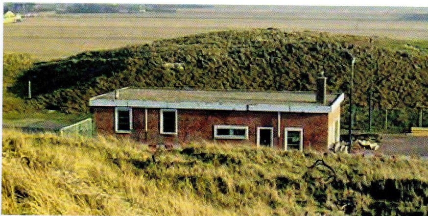
Foto 2 Het machinegebouw wat intussen is gesloopt
