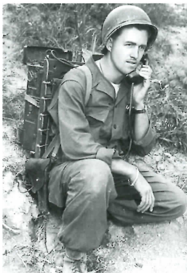
Een tijdens WO2 veel gebruikte draagwijze van de SCR-300 was op een standaard US-Army packboard
