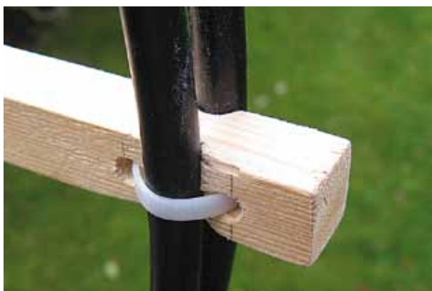
Foto 5: Close-up bevestiging RG-213 aan de dwarslatjes.
