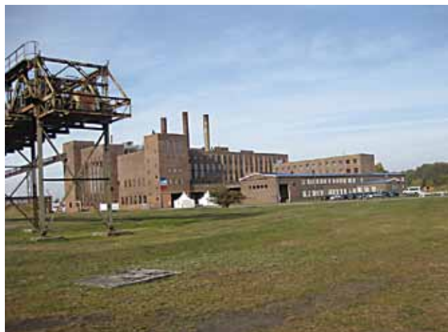
Foto 5: De elektriciteitscentrale, praktisch onbeschadigd na het geallieerde bombardement. Links nog een stukje te zien van de kolenlosinstallatie.
