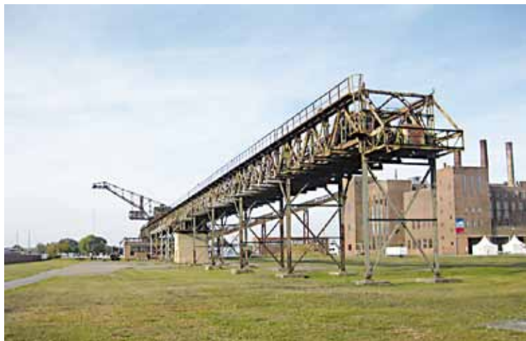
Foto 6: De kolen-losinstallatie met op de achtergrond de transportband naar de ketels in de centrale.
