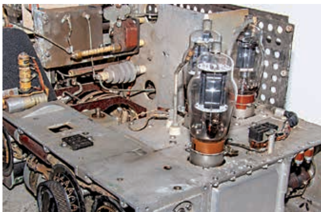
Foto 5: Buizen die op de voet staan in plaats van dat ze er goed zijn ingestoken!
