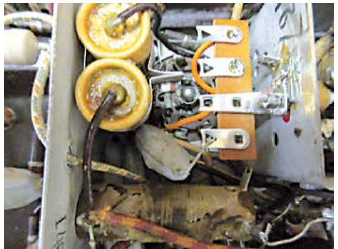
Foto 4: Draadsteun op bestaande schroef
