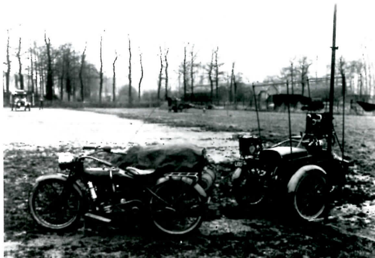
Foto 20. Radiostation gemonteerd in het zijspan van een Harley Davidson. Links gereed voor transport, rechts klaar voor gebruik. De radio is een vliegtuig-installatie die we niet verder thuis hebben kunnen brengen.
